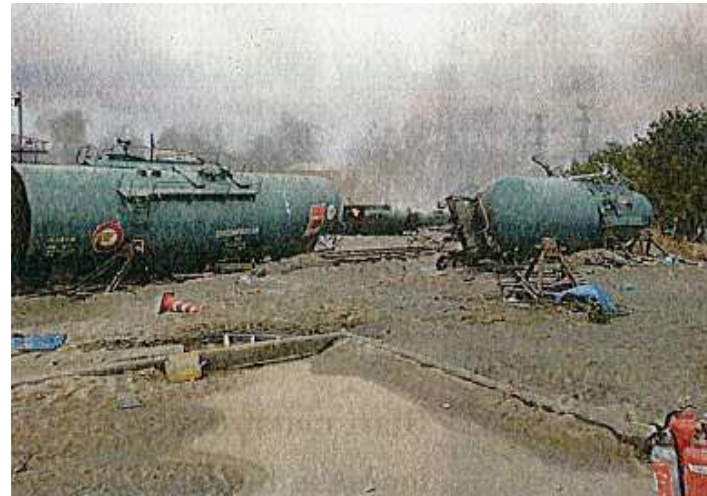
Réservoir sous pression: renversement (Japon-Tsunami 2011)
