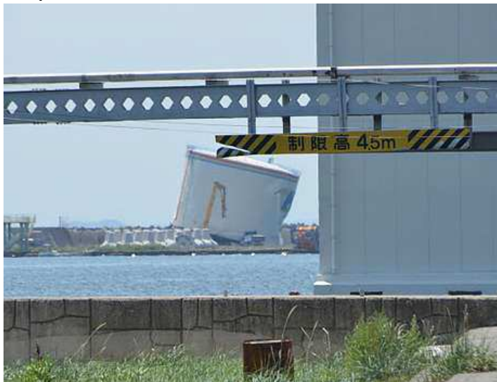
Réservoir atmosphérique: Soulèvement, glissement, renversement (Japon-Tsunami 2011)
