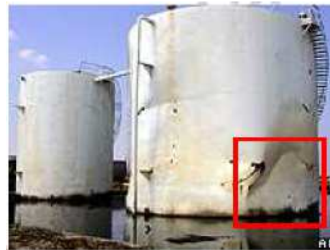
Impact d'objet flottant (Japon-Tsunami 2011)
