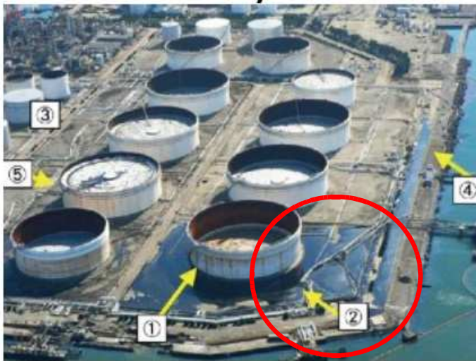
Tuyauterie arrachée (Japon-Tsunami 2011)
