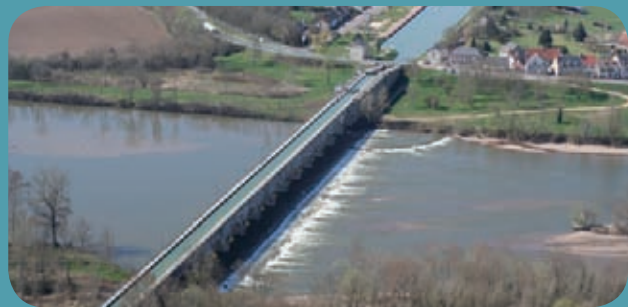
Le pont-canal du Guétin sur l'Allier
