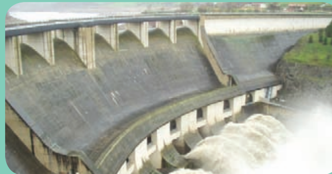
Le barrage de Villerest lors de la crue de 2003
