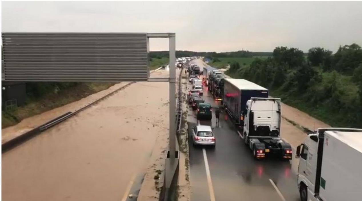
Coupure de l'A36 à proximité de Belfort 04/06/2018 : orage, ruissellement et coulée boueuse
