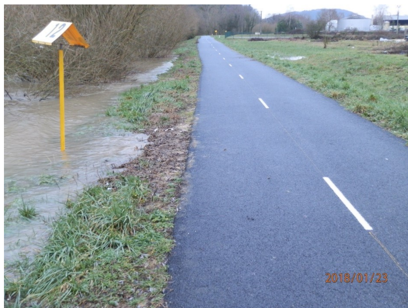
Digue PL8 à Audincourt
