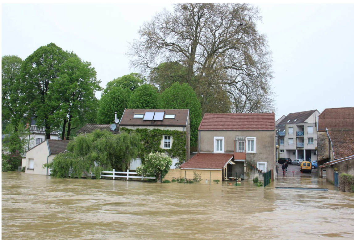
débordements de l'Ouche à Longvic - crue de mai 2013
