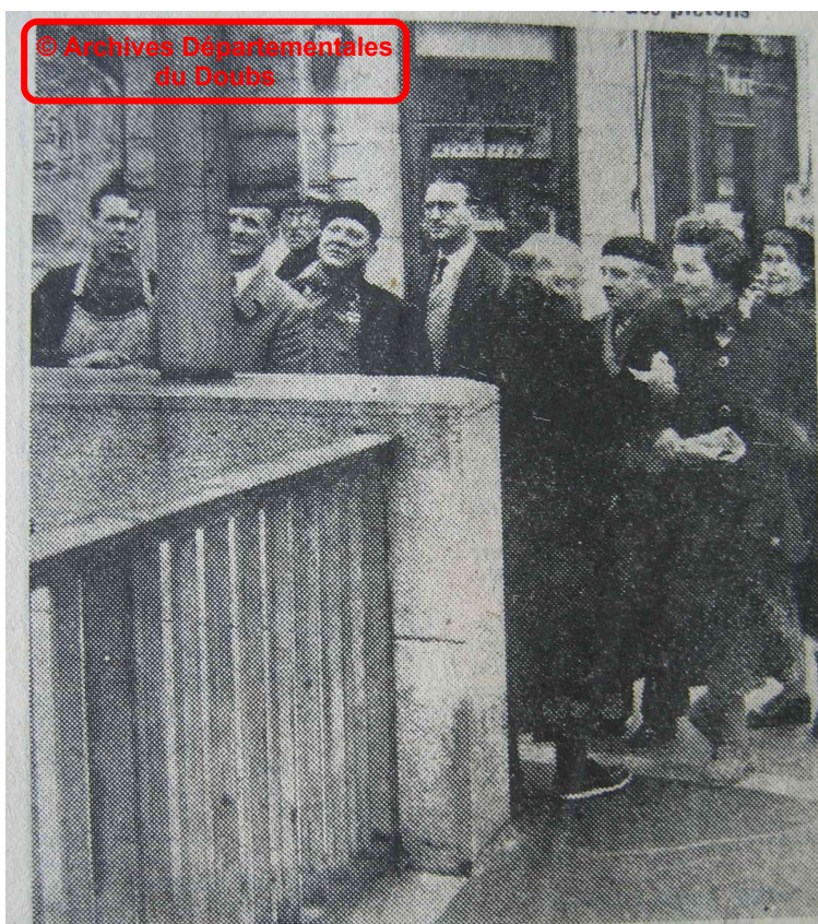
Au pont Battant, où était affichée l'évolution de la crue, toute la journée les Biontins inquiets se sont pressés, hier mardi, pour surveiller le niveau...
