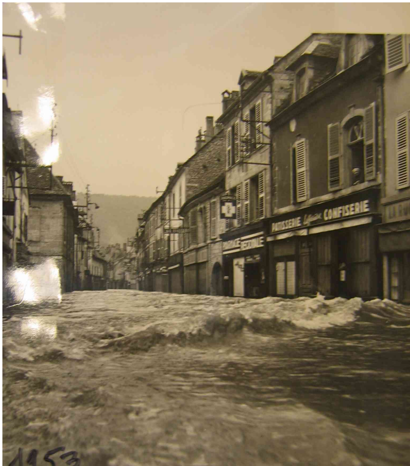
Photo des inondations de 1953 à Ornans, 1953 (Bibliothèque et archives municipales de la ville d'Ornans)
