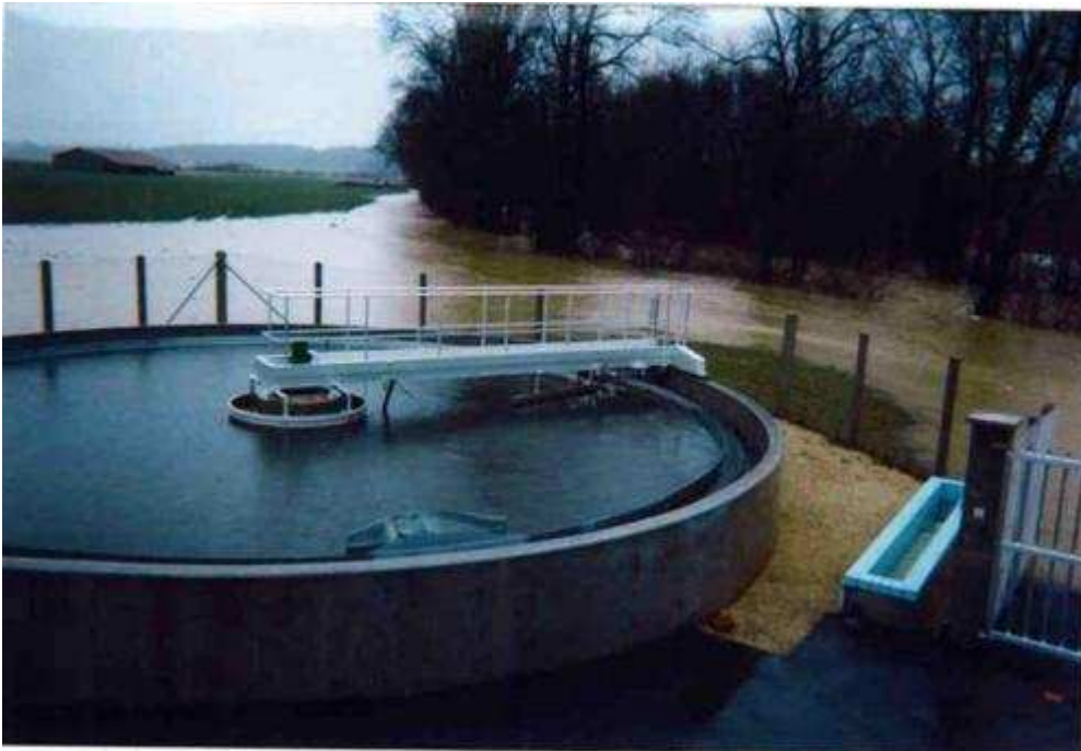
La station d'épuration
