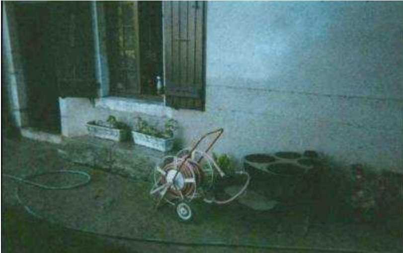
Moulin du Milieu : après la crue
