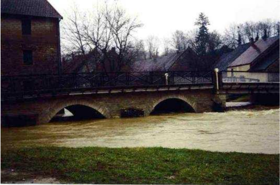
Le pont de la rue Saint-Vincent : vue depuis l'aval
