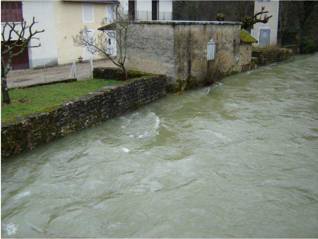
Vue depuis le pont vers la rive droite en amont
