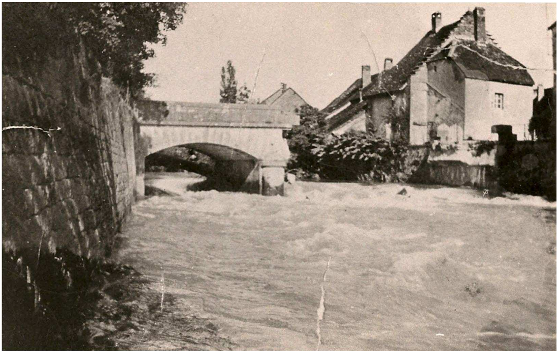
Vue depuis l'aval
