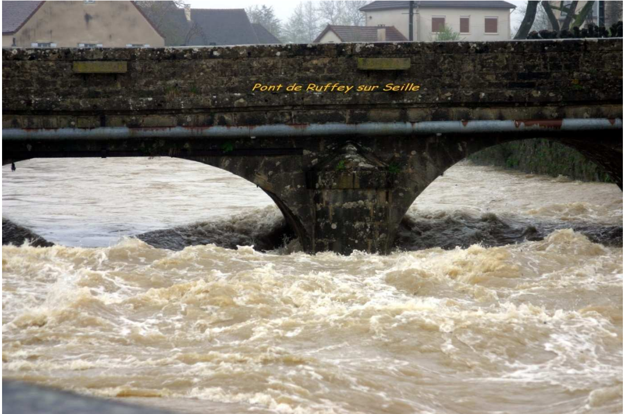
Vue du pont de Ruffey, depuis l'aval
