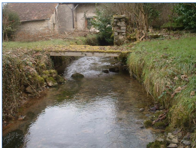
Figure 121. Localisation et vue de la station REN20.
