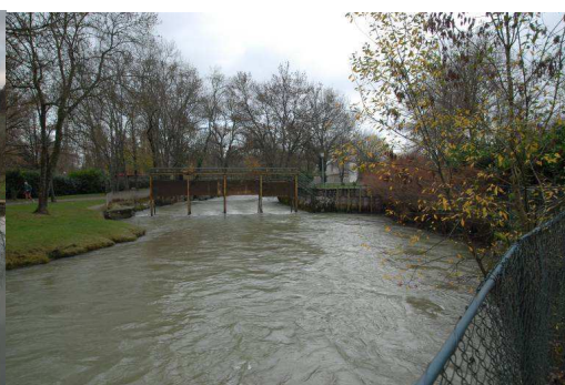
Image 5 : prise d'eau sur l'Ouche à Larrey
