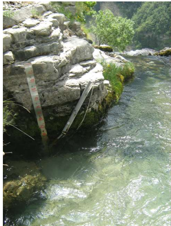
Figure 6 - Site de mesure installé à une émergence. Il est équipé d'une échelle limnimétrique et d'un tube de tranquillisation qui contient une sonde de mesure des hauteurs et des températures d'eau. Les relations hauteur/débit sont calibrées avec des jaugages au sel dans différentes conditions hydrologiques. Seuls les gros débits de crue n'ont pu être jaugés du fait de la difficulté d'accès dans des conditions de ce type. Malgré la hauteur d'eau et le débit important, la température mesurée se trouve influencée par le rayonnement solaire lors de fortes insolation. Ce phénomène s'observe plus particulièrement lors de l'étiage estival (Photo Philippe Audra).
