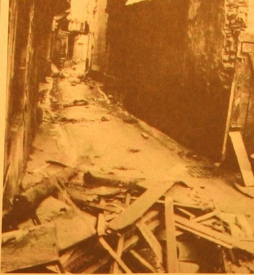
Le passage du bief des Sept Fontaines
