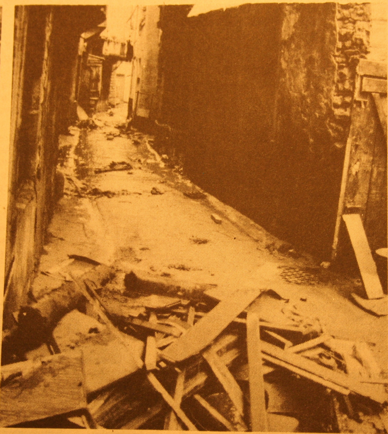
Le passage du bief des Sept Fontaines
