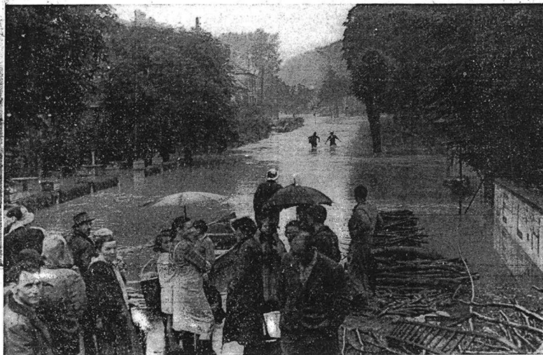
A Port-Lesney envahi par l'eau, les habitants, s'abritant sous les parapluies — car il pleut toujours ! — assistent aux travaux de sauvetage.
