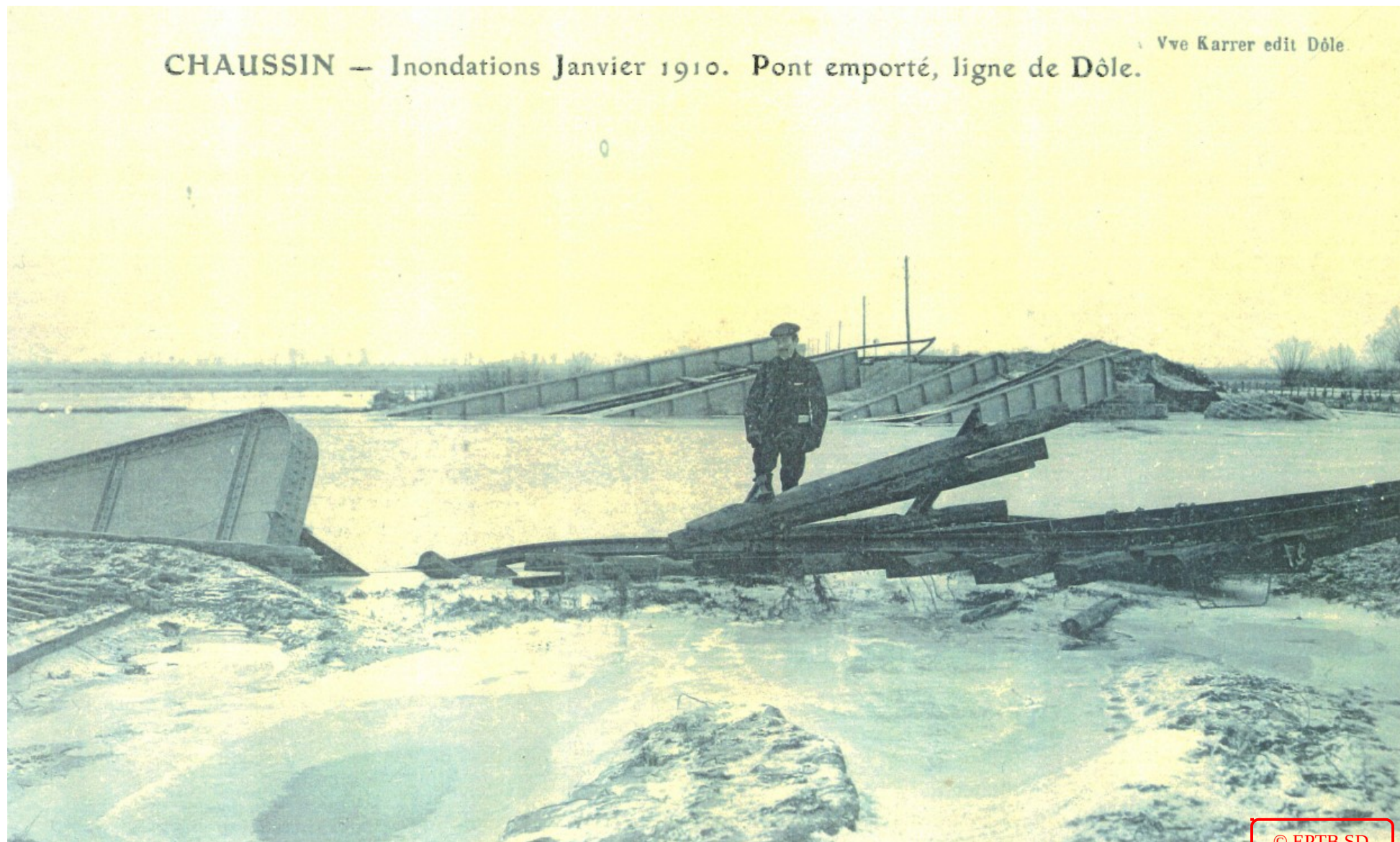
Photographie d'un pont de la ligne de Dole emporté à Chaussin, suite à la crue du Doubs en Janvier 1910 (Établissement Territorial du Bassin Saône et Doubs) (DMD39)
