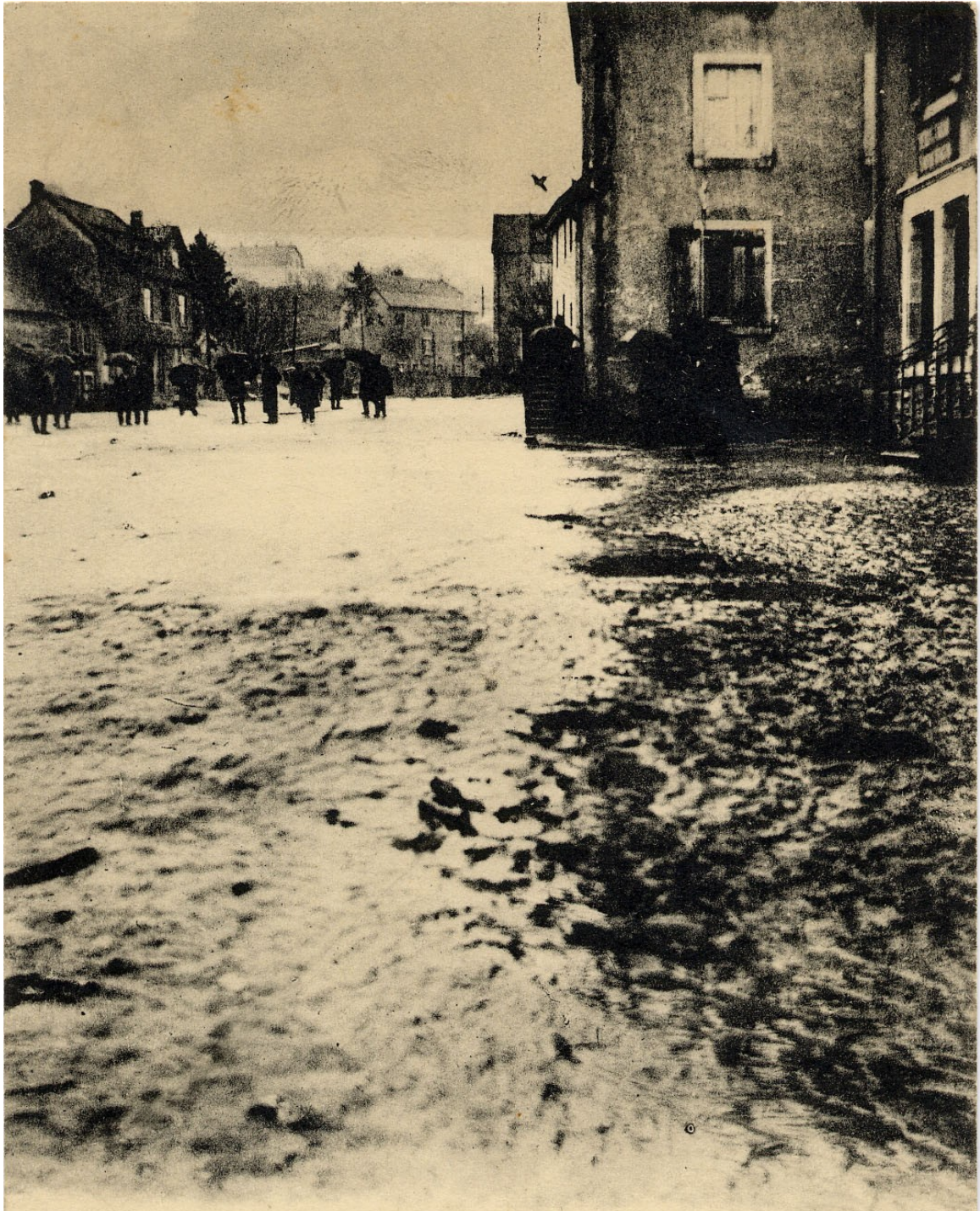
Inondation du 20 Janvier 1910 1172. - SELONCOURT. - Rue Viette
