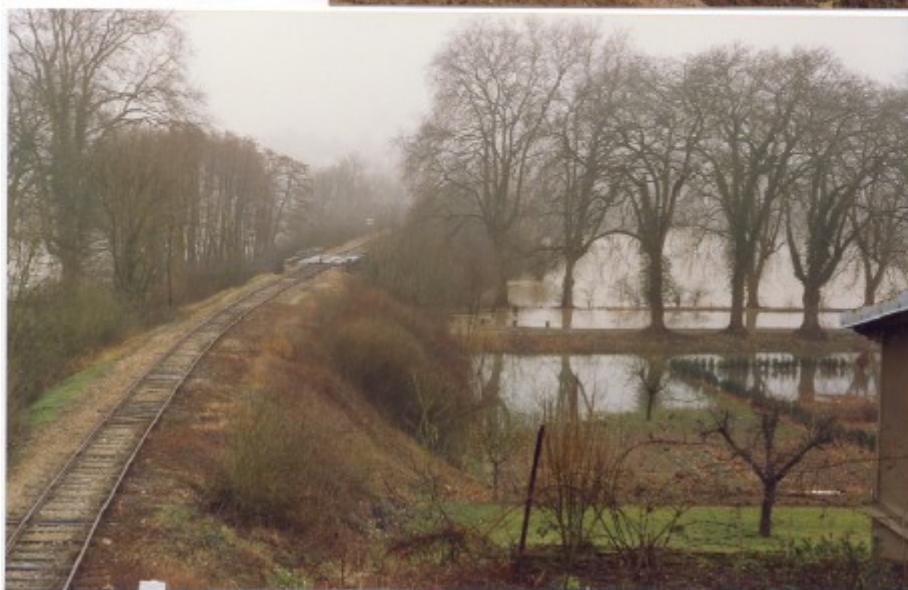
Bref 65/66 vu depuis la rue des Comuards à Dole
