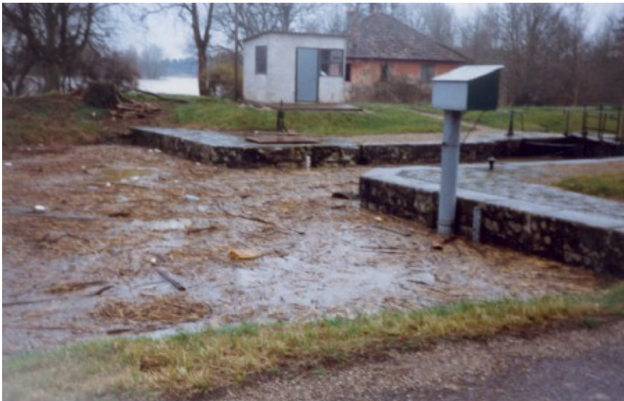
Dole — l'écluse 68 de la Prise d'eau
