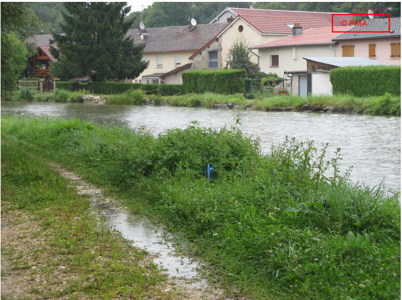
« Piquetage de la brèche »
