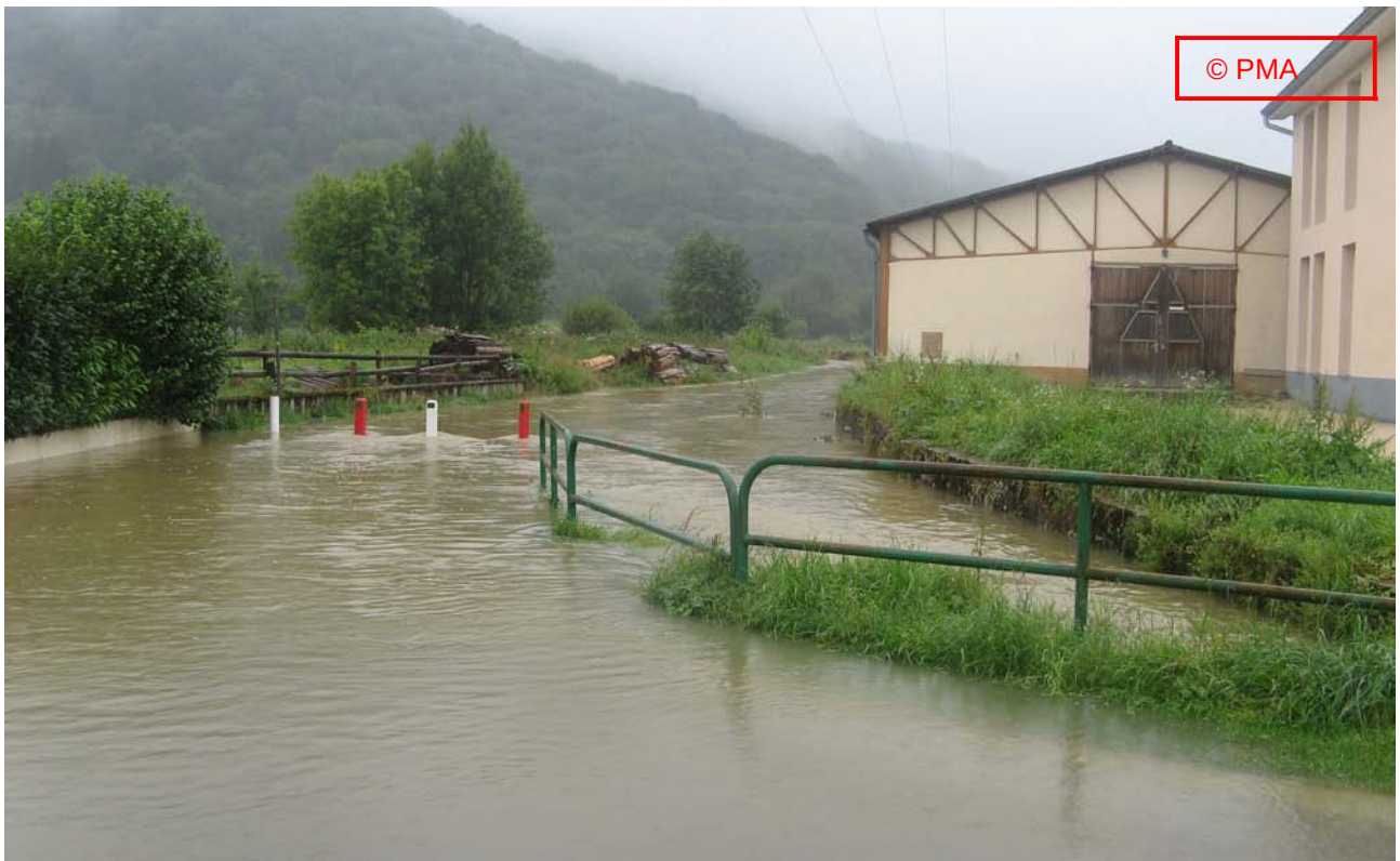
« Contre fossé du Rupt à Bart »
