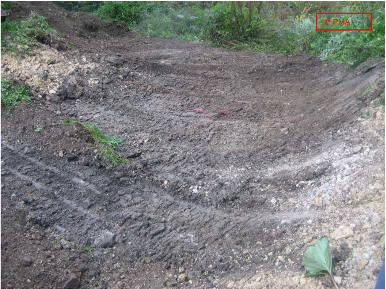
« Brèche ouverte à Voujeaucourt »
