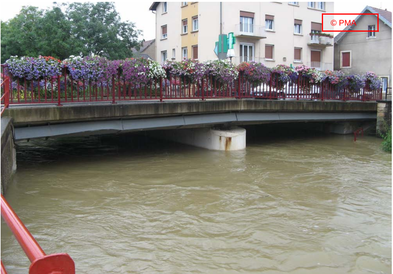
« Le Rupt à Bart »
