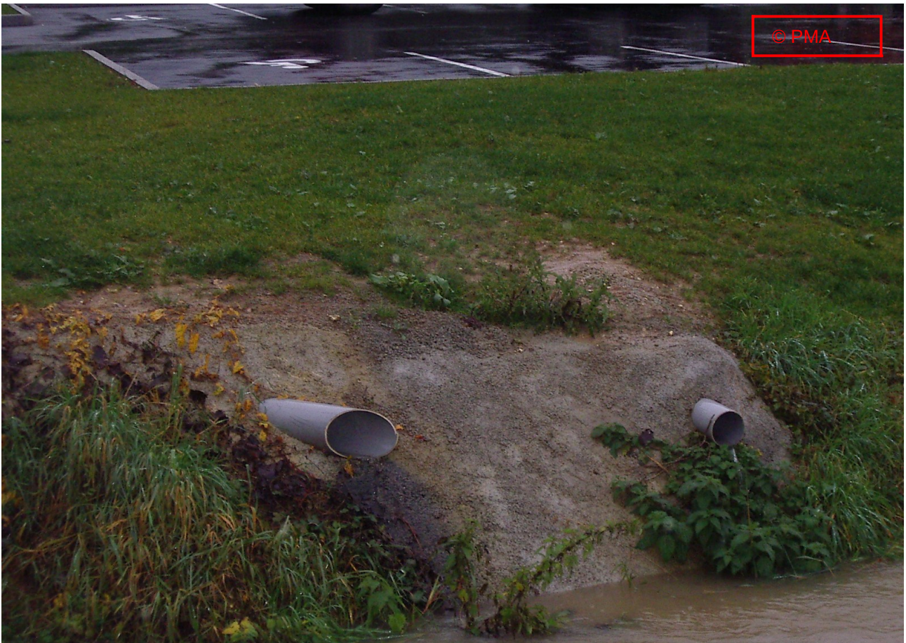
« Exutoire du parking Voironnes »
