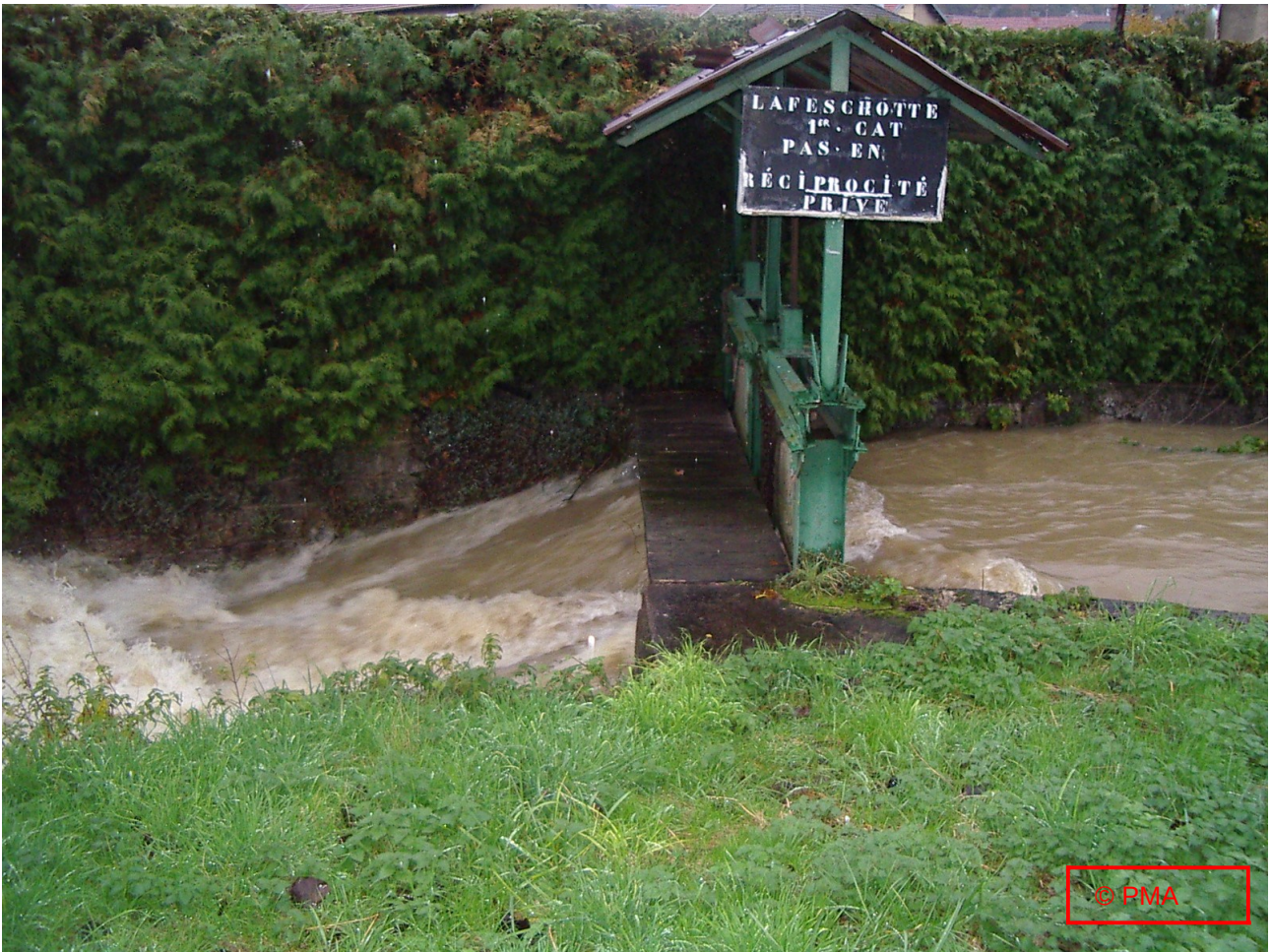
« Vanne de la diffluence »
