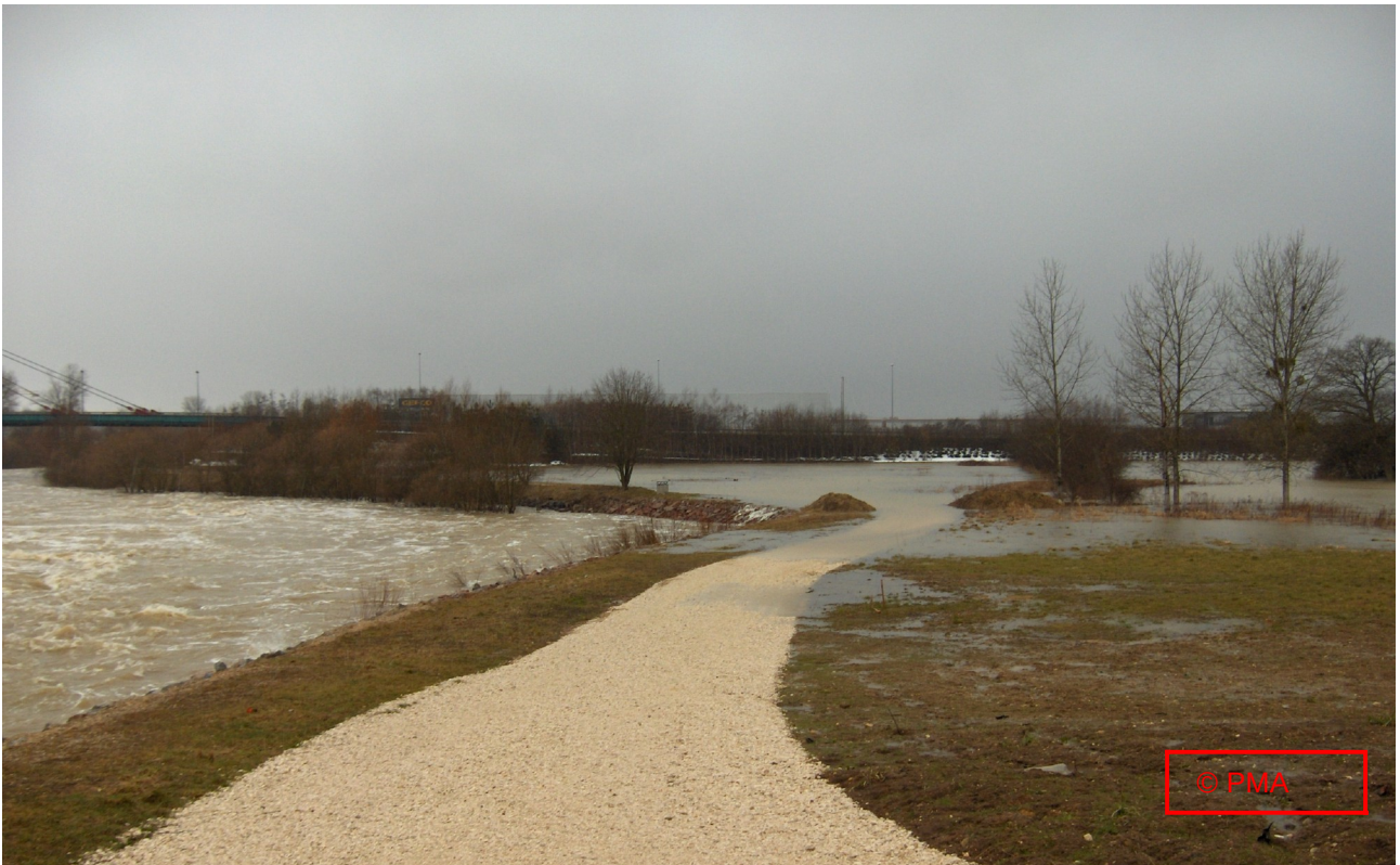
« Bassin de compensation Allan - Technoland »
