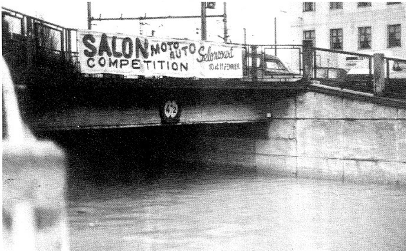
Le grand passage sous rail... Ce qu'il en reste.
