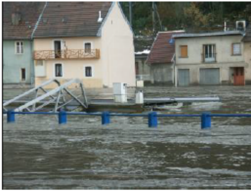
Place du Gravier, le ponton d'amarrage pour les bateaux de plaisance a été chahuté par les flots en furie.
