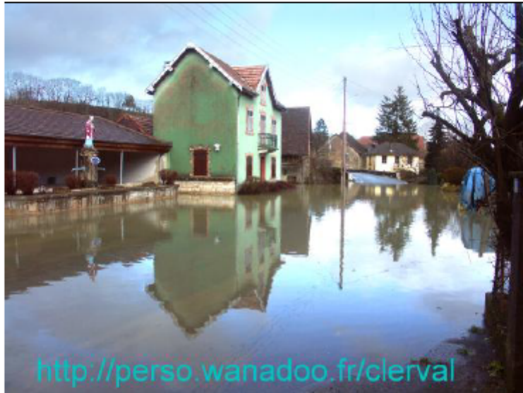
A Pompierre-sur-Doubs, le ruisseau de la Soye avait envahi la partie basse du village, coupant l'accès au vieux pont. Un petit lac s'est formé sur la place devant la fontaine Saint-Léger (ici vers 15 h)
