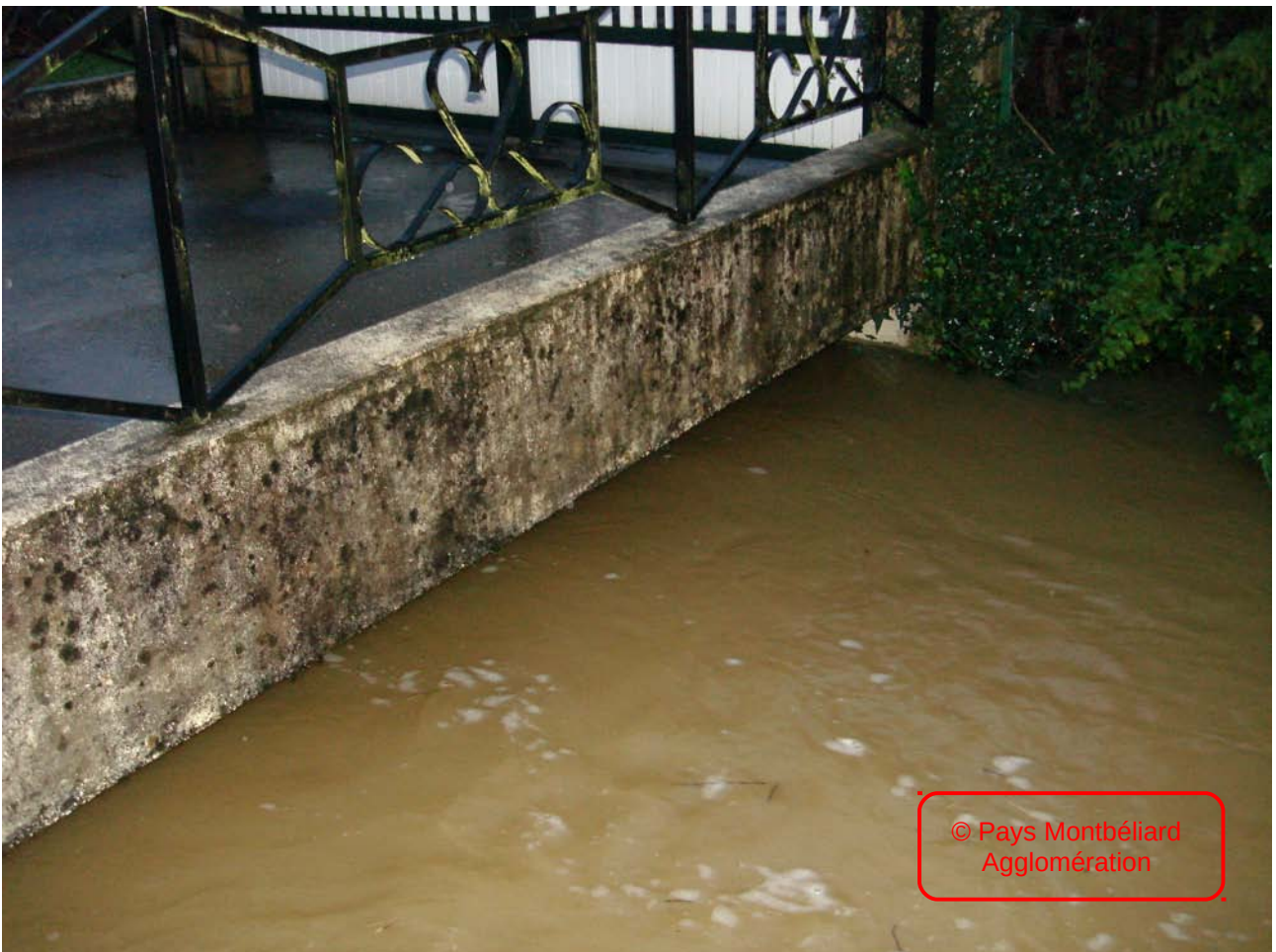
13 septembre - passerelle Broner
