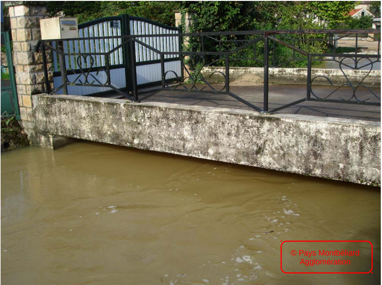
14 septembre - passerelle Broner
