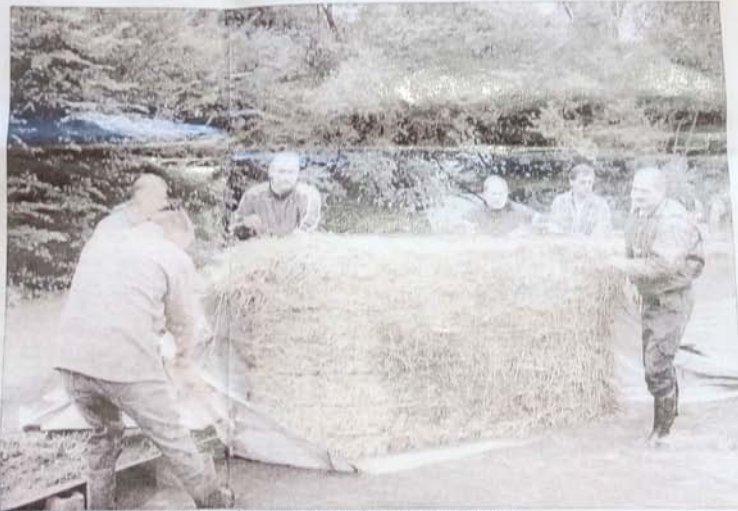
■ Pour lutter contre les inondations, un groupe d'habitants installe un barrage de bottes de paille.
