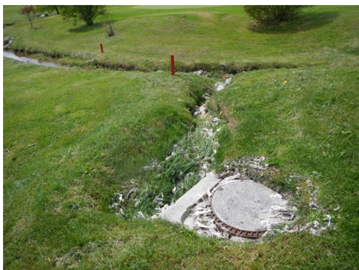
FIGURE 3.22 – Poste de relevage situé au sein d'un golf et ayant débordé récemment (6 juin 2014)
