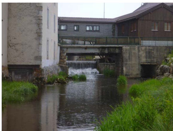
FIGURE 3.13 – Vue de l'ouvrage dit de « la Boissellerie » à Bois d'Amont - Cliché P. Durllet
