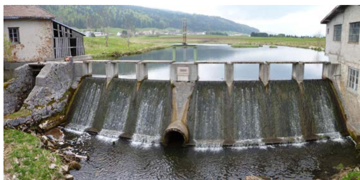
FIGURE 5.1 – Vue du seuil dit de « des Meuniers » - Cliché P. Durllet
