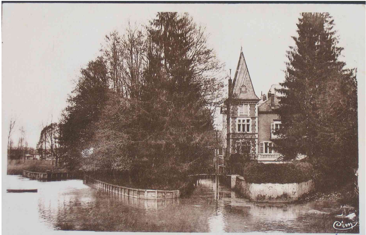
Carte Postale des inondations à Saint-Loup-sur-Semouse Villa des Pervenches – non datée (Archives départementales de la Haute Saône)
