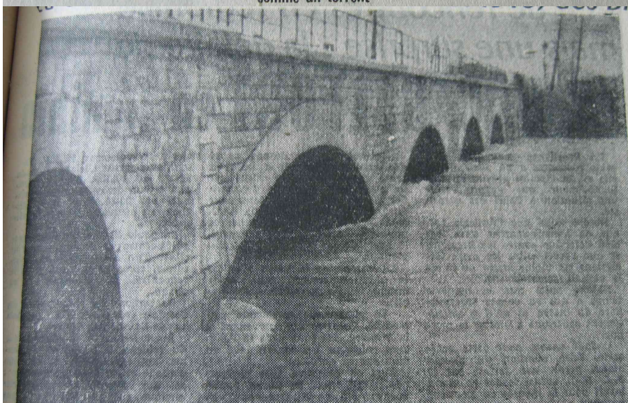
Au plus fort de la crue de jeudi (cote 5,37) à Voujaucourt, le pont du chemin de fer montre bien l'influence des piles sur le niveau d'eau amont
